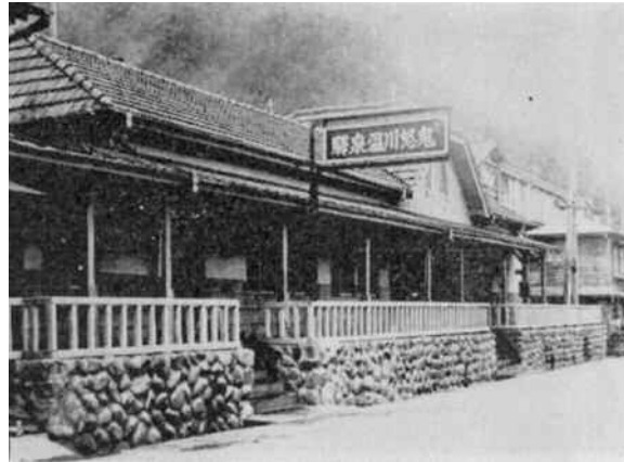
下野電鉄時代の鬼怒川温泉駅 (東武鉄道買収後も現在地へ移設するまで使用された)
