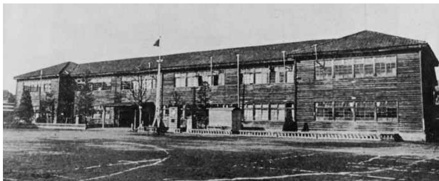
宇都宮市立西小学校 昭和21年9月19日 地鎮祭 // 25年11月15日 完工
